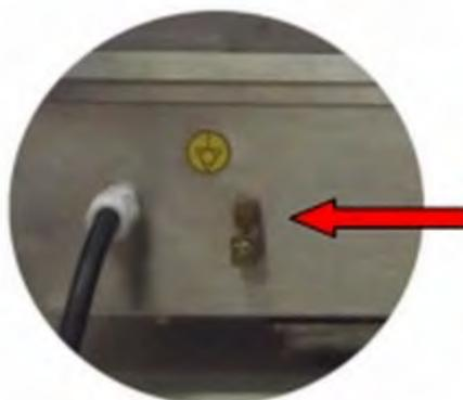
O terminal é utilizado para equalizar os potenciais elétricos entre diferentes equipamentos ligados à rede elétrica, diminuindo ao máximo riscos de choques elétricos.
